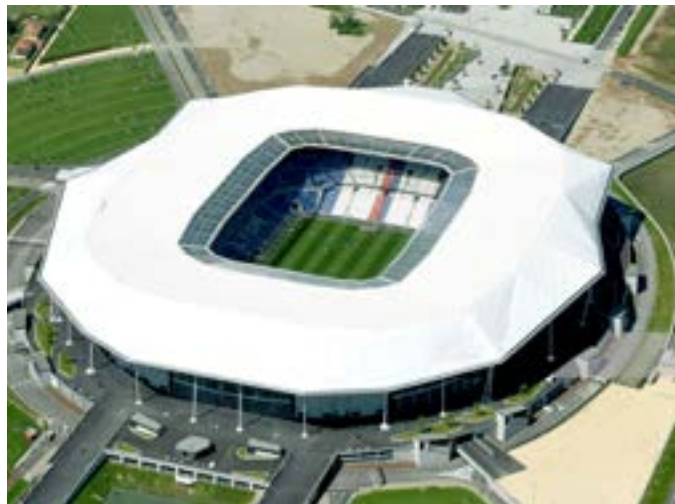
Grand Stade de Lyon Stade des Lumières - Lyon (France)
